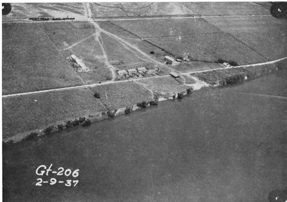
Fig. 140 — Vista aérea de um trecho do dique do Paraíba em Campos (AerofotoTe. Kafuri, do D.N.O.S.)
