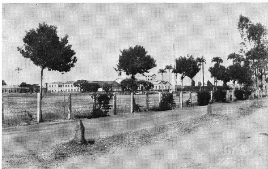
Fig. 131 — Usina do Queimado. Campos
