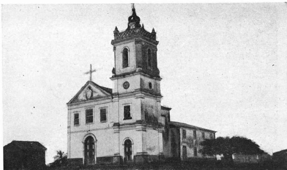
Fig. 118 — Igreja de N. S. da Boa Morte, em São João-da-Barra. Século XIX (Foto A. R. Lamego)
