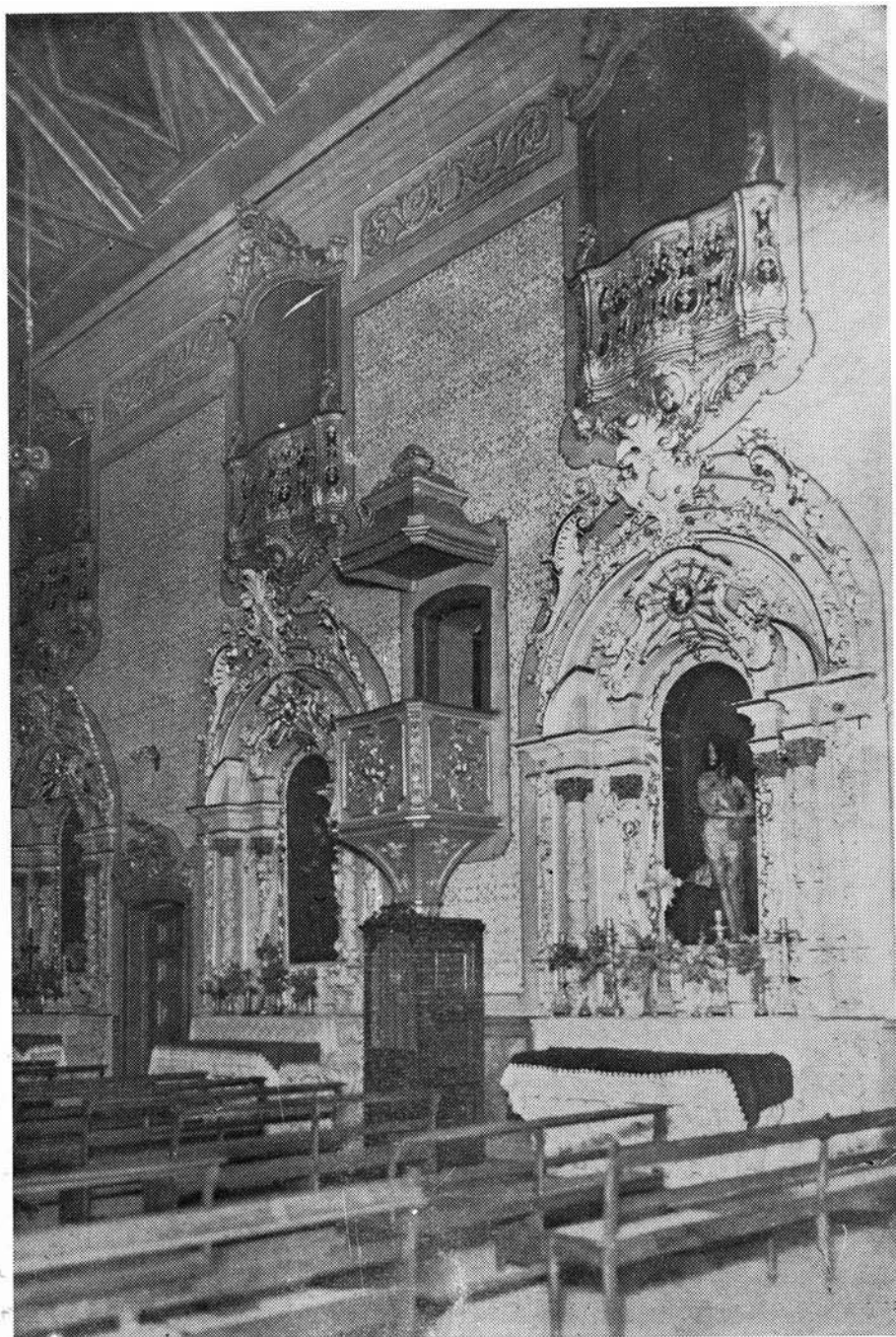
Fig. 117 — Interior da igreja do Carmo, em Campos, com belos trabalhos de talha, nos altares laterais e nas tribunas
