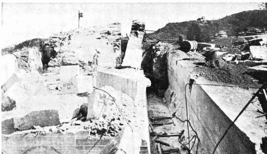
Fig. 40 — Exploração de mármore branco nas jazidas de Monção, no município de Campos
