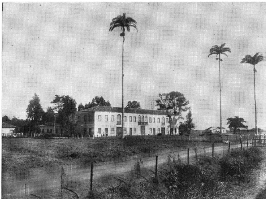
Fig. 86 — "Airises", construído há cem anos pelo comendador Cláudio do Couto e Sousa na margem direita do Paratba, em Campos
