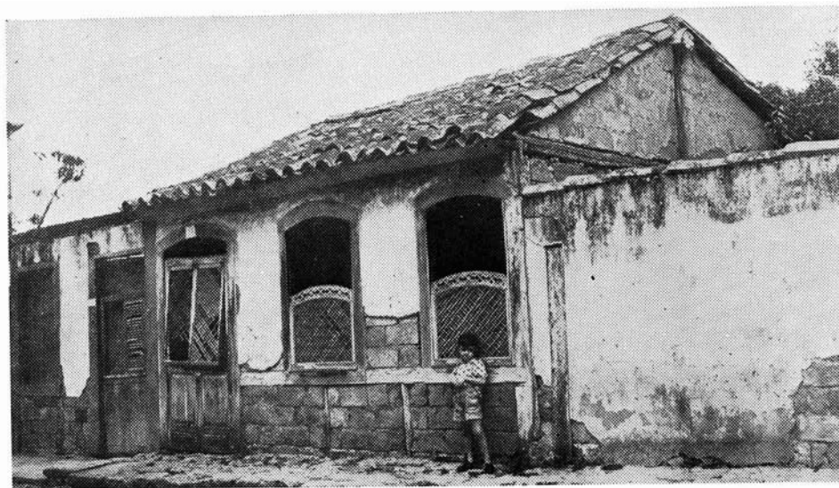
Fig. 63 — Velhíssima casa em São João-da-Barra, com rótulas nas portas e janelas (Foto A. R. Lamego)
