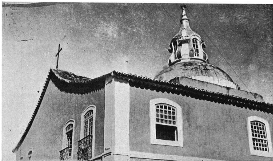
Fig. 115 — Parte posterior e cúpula da igreja do Rosario, em Campos. A fachada foi desfigurada pela reforma recente
