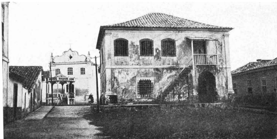
Fig. 106 — A cadeia colonial de São João-da-Barra, com paredes de pedra e cal de 1.20 de espessura
