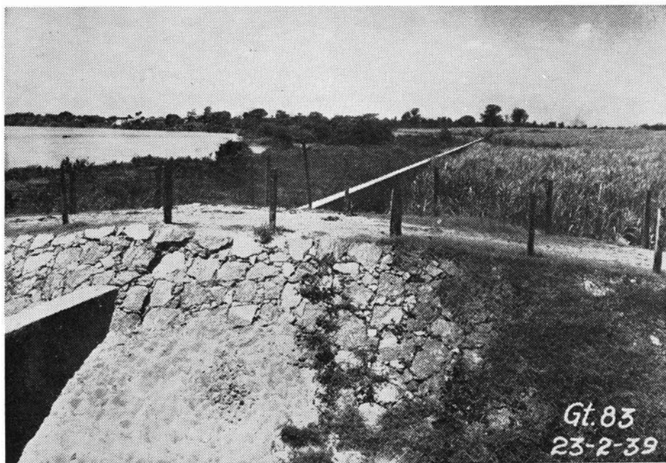
Fig. 139 — O dique de alvenaria construído pelo D.N.O.S. para reter as enchentes do Paraíba em Campos
