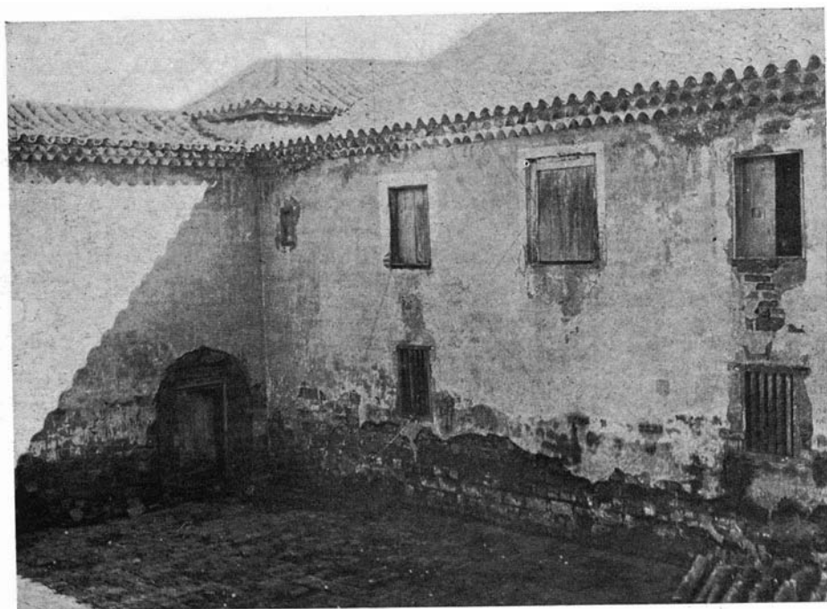
Fig. 56 — Pormenores do telhado e do pátio interno do Colégio (Foto A. Quintela)
