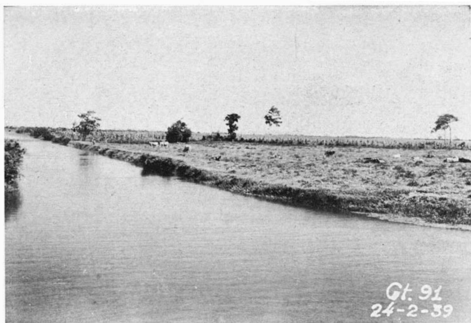
Fig. 26 — O canal Macaé-Campos cortando aluviões da planície. (Foto do D.N.O.S.)
