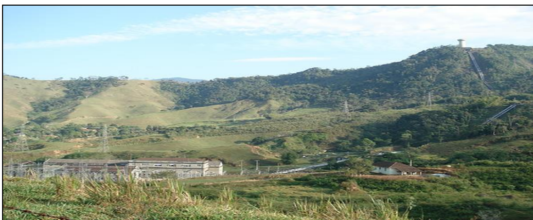
Figura 2 – PCH Macabu e Tubulação em Queda de 336m após transposição por túnel subterrâneo. Fonte: Quanta Geração S/A, 2012. Disponível em: www.quantageracao.com.br
